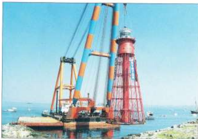
Här hänger Pater Nosters fyr i kranen på pontonkranen SAMSON. Den 132 ton tunga fyren flyttades bort från Hamneskär 30 juli 2002. Foto: Esbjörn Hillberg
